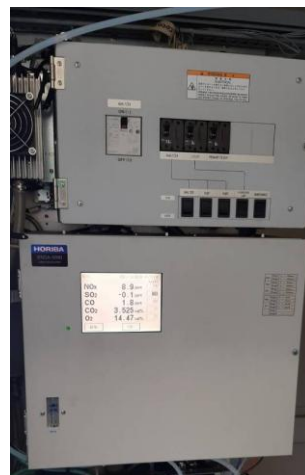
รูปที่ ช.2-1 ระบบตรวจสอบคุณภาพอากาศจากปล่องแบบต่อเนื่อง (CEMS)
