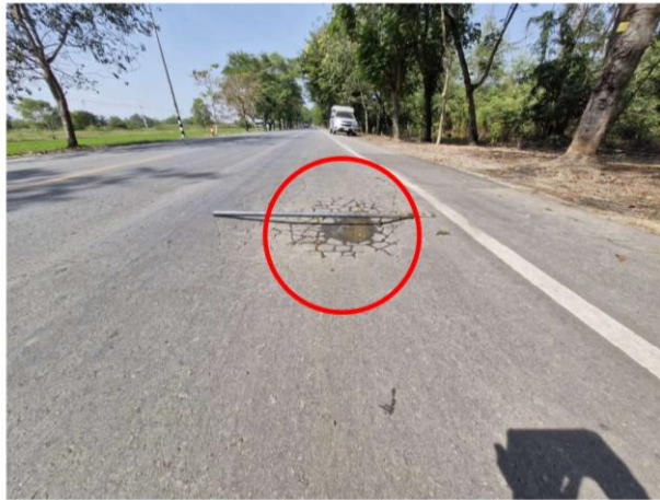
ถนนทรุดตัวตลอดแนวช่วงบริเวณที่เคยท่อน้ำประปาแตก บางจุดทรุดตัวมากตามรูป
