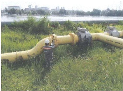
(ก) การทดสอบและตรวจสอบอุปกรณ์นิรภัยแบบระบาย (Safety Valve) ของสถานที่ใช้ก๊าซธรรมชาติ
