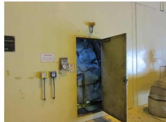
รูปที่ ข.3-2 รูปห้องคลุมเครื่องจักรบริเวณห้องเผาไหม้ของเครื่องกังหันก๊าซ
