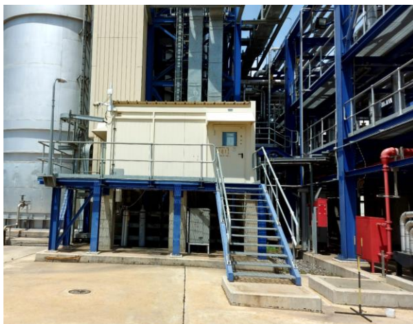
รูปที่ ช.2-1 ระบบตรวจสอบคุณภาพอากาศจากปล่องแบบต่อเนื่อง (CEMS)
