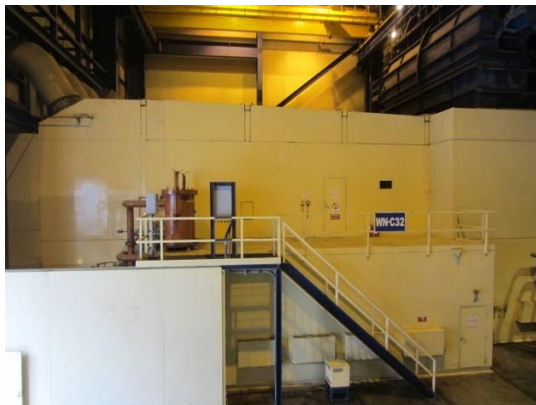
รูปที่ ข.3-2 รูปห้องคลุมเครื่องจักรบริเวณห้องเผาไหม้ของเครื่องกังหันก๊าซ
