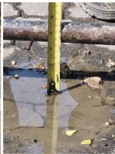
ถนนทรุดตัวตลอดแนวช่วงบริเวณที่เคยท่อน้ำประปาแตก บางจุดทรุดตัวมากตามรูป
