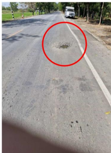
ถนนทรุดตัวตลอดแนวช่วงบริเวณที่เคยท่อน้ำประปาแตก บางจุดทรุดตัวมากตามรูป
