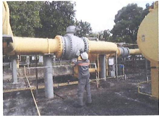
(ก) การทดสอบและตรวจสอบอุปกรณ์นิรภัยแบบระบาย (Safety Valve) ของสถานที่ใช้ก๊าซธรรมชาติ
